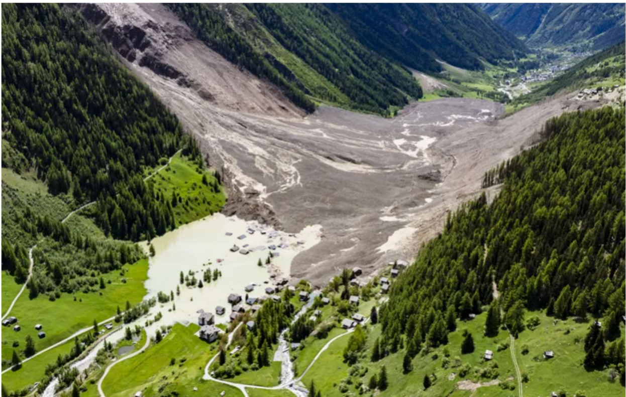
Dorf Blatten, Wallis nach Gletscherabbruch vom 28.Mai 2025
